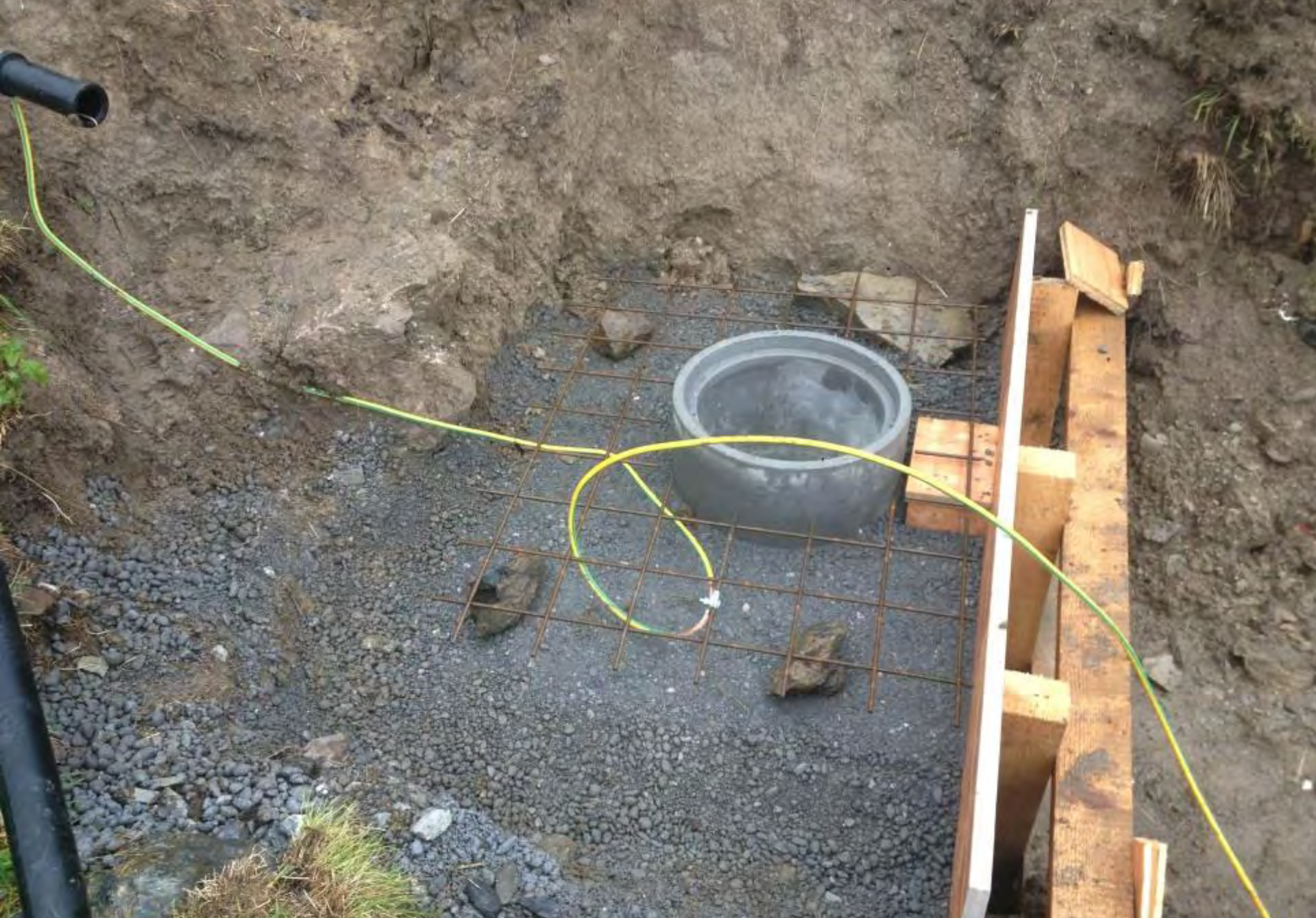
Vorarbeiten für Turbinenfundament
