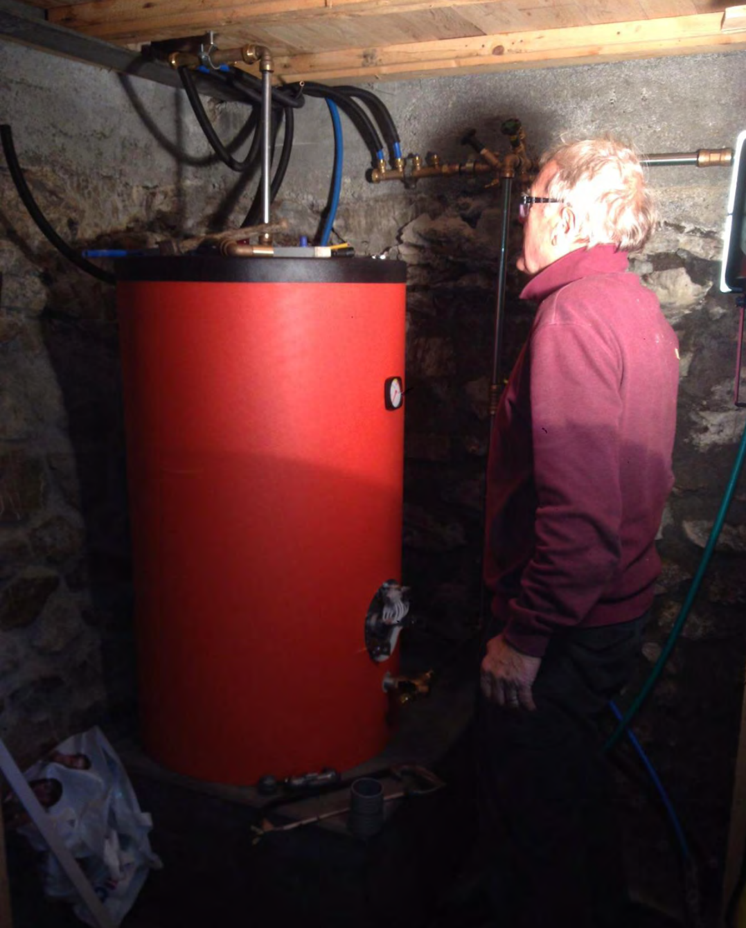
Ernst Lüdi bei der Haustechnikmontage
