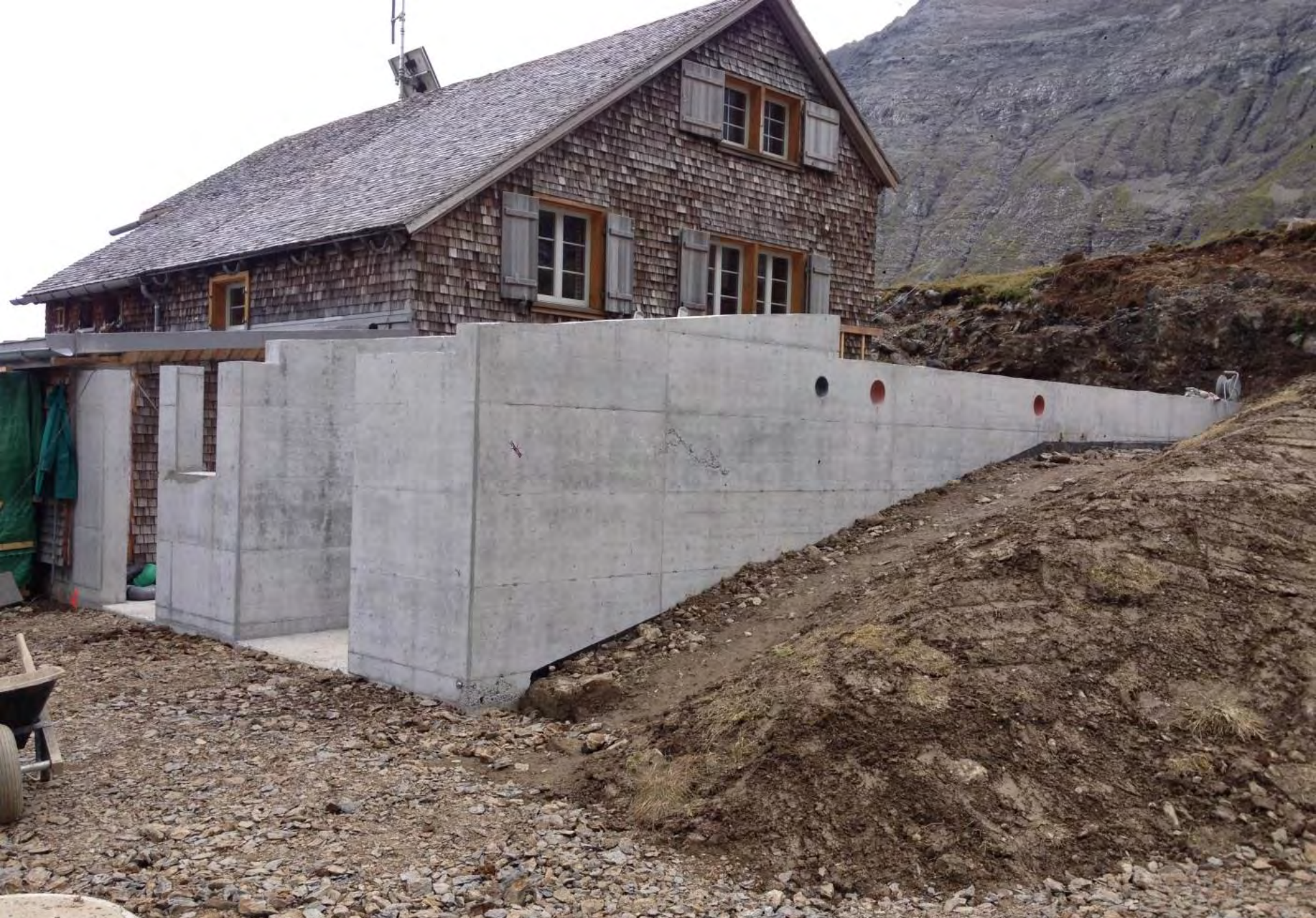
Fertige Kellerwände mit Umgebung und Lawinenschutz
