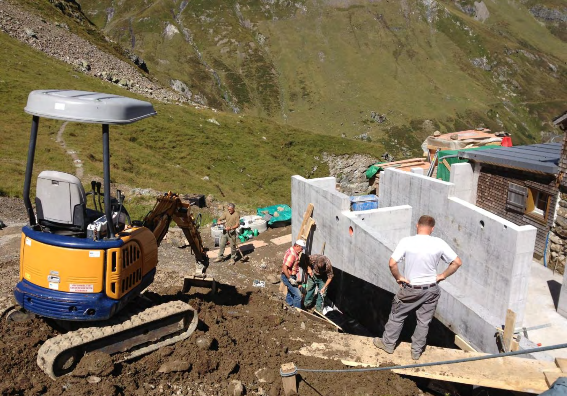
Umgebungsarbeiten beim Turbinenhaus
