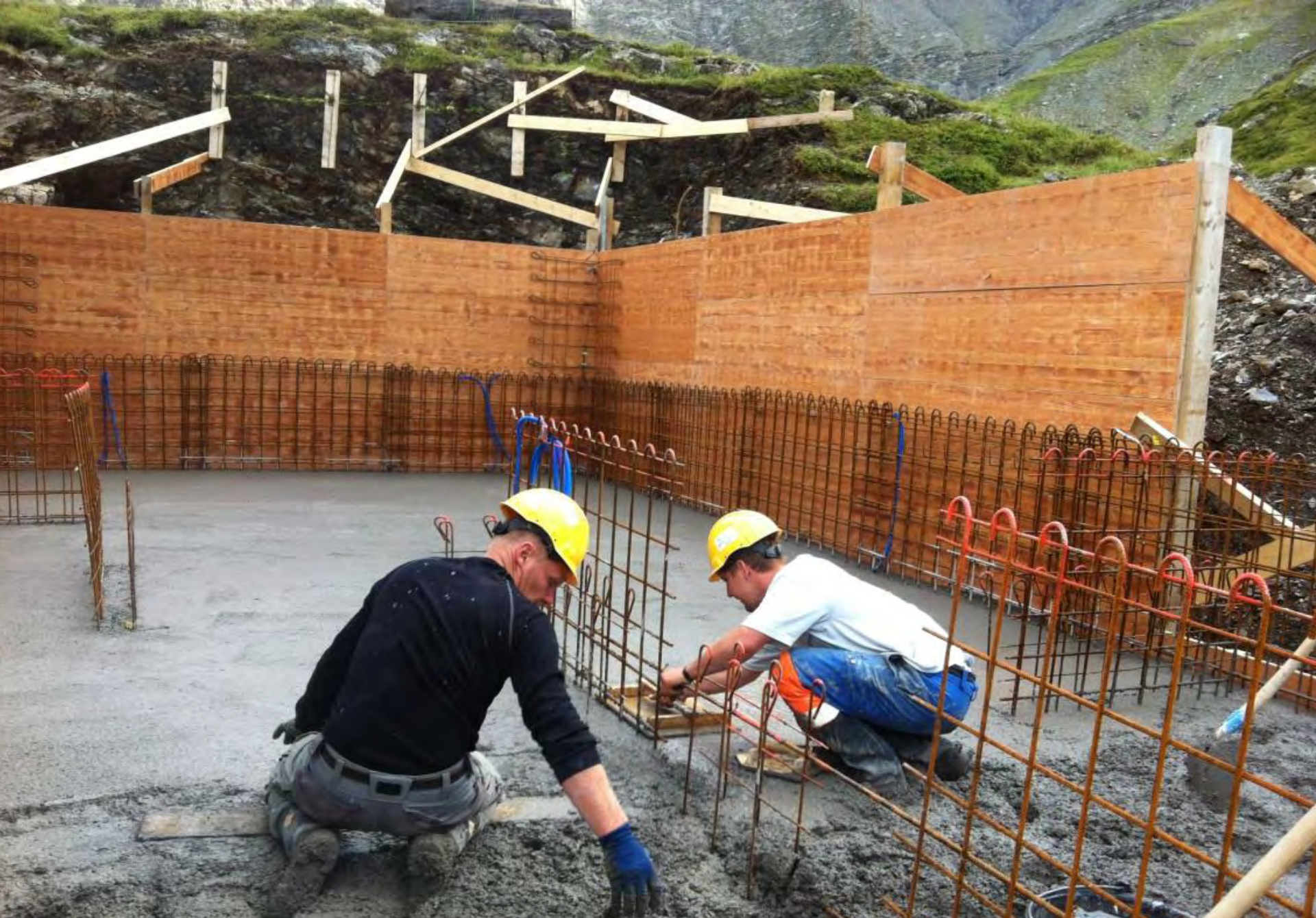
Bodenplatte betonieren
