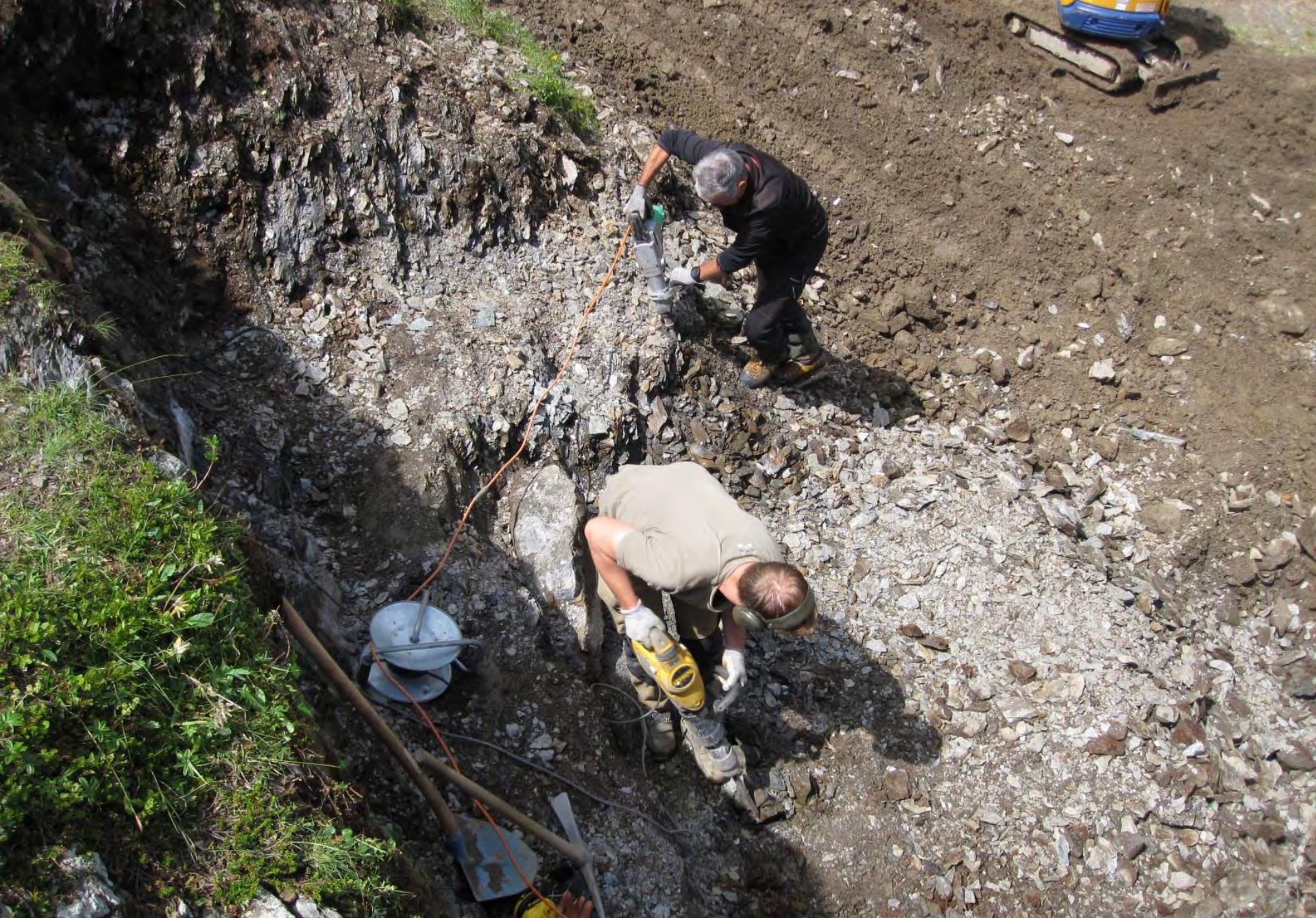
Spitzarbeiten am Fels
