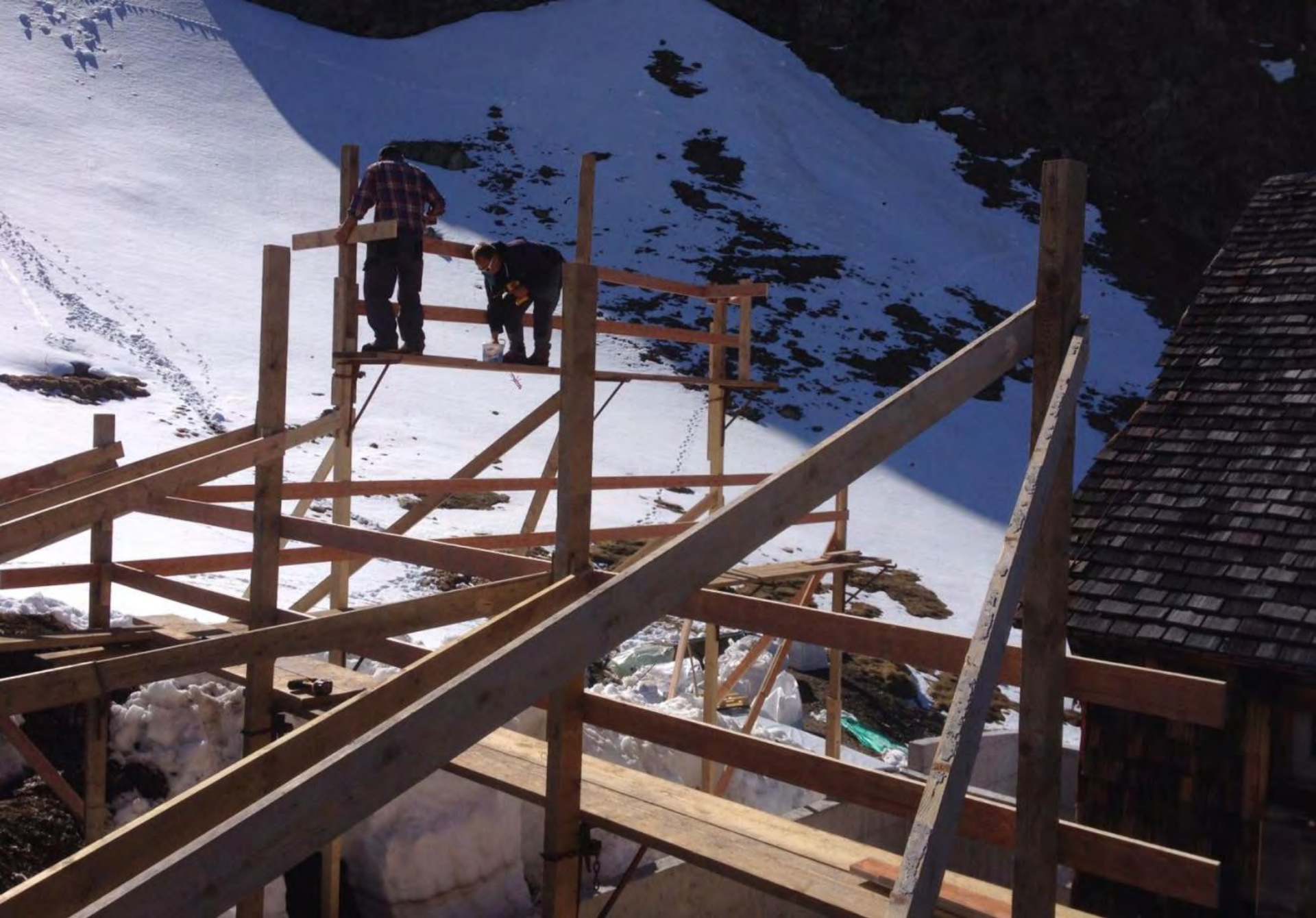
Gleichzeitige Gerüstarbeiten im Aussenbereich
