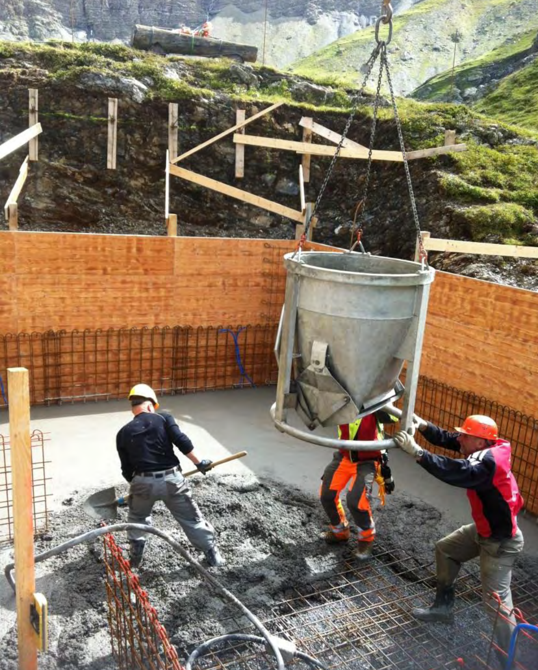
Bodenplatten mit Heli betonieren
