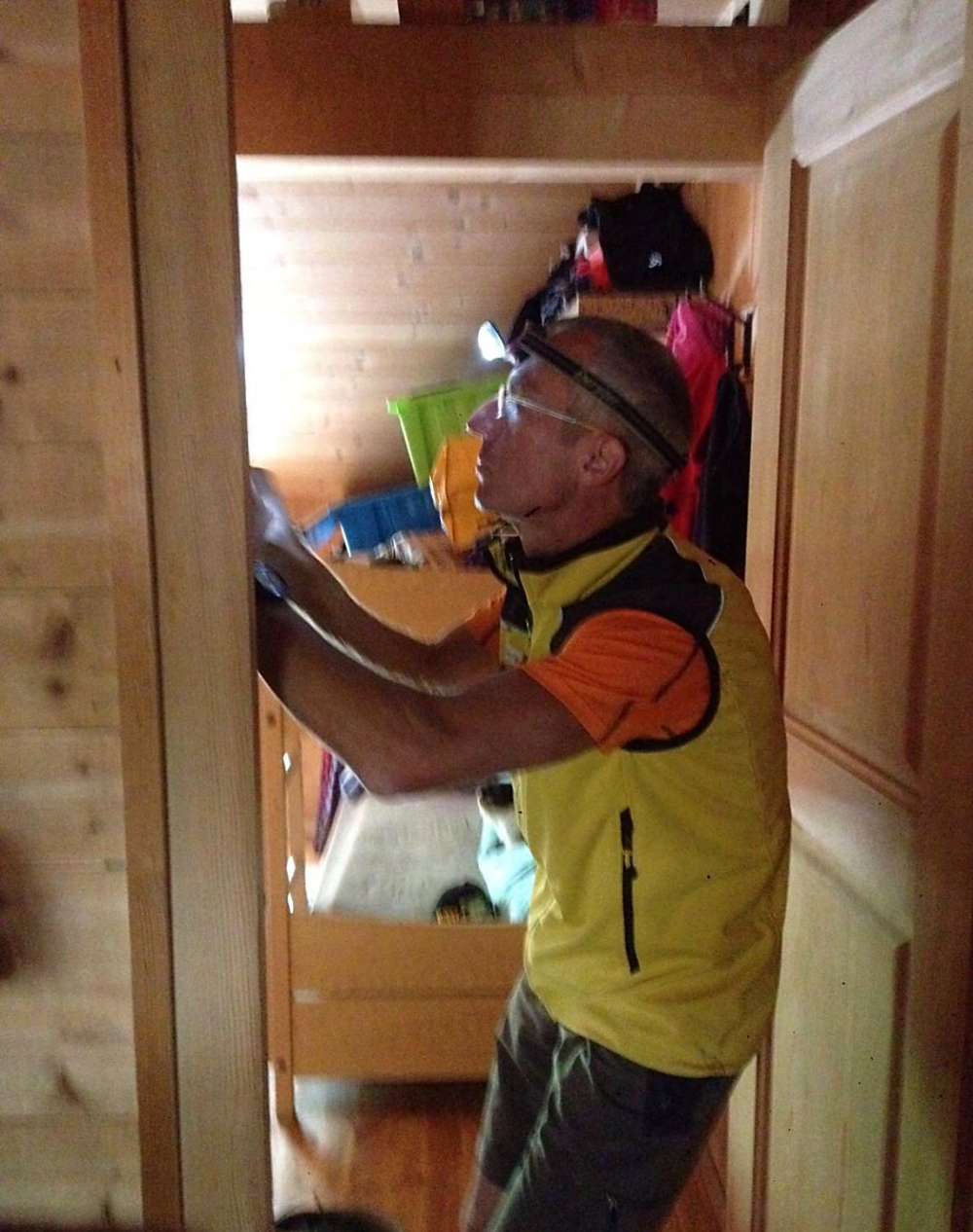
Präsident René Kistler während der Arbeiten von der Elektroinstallation
