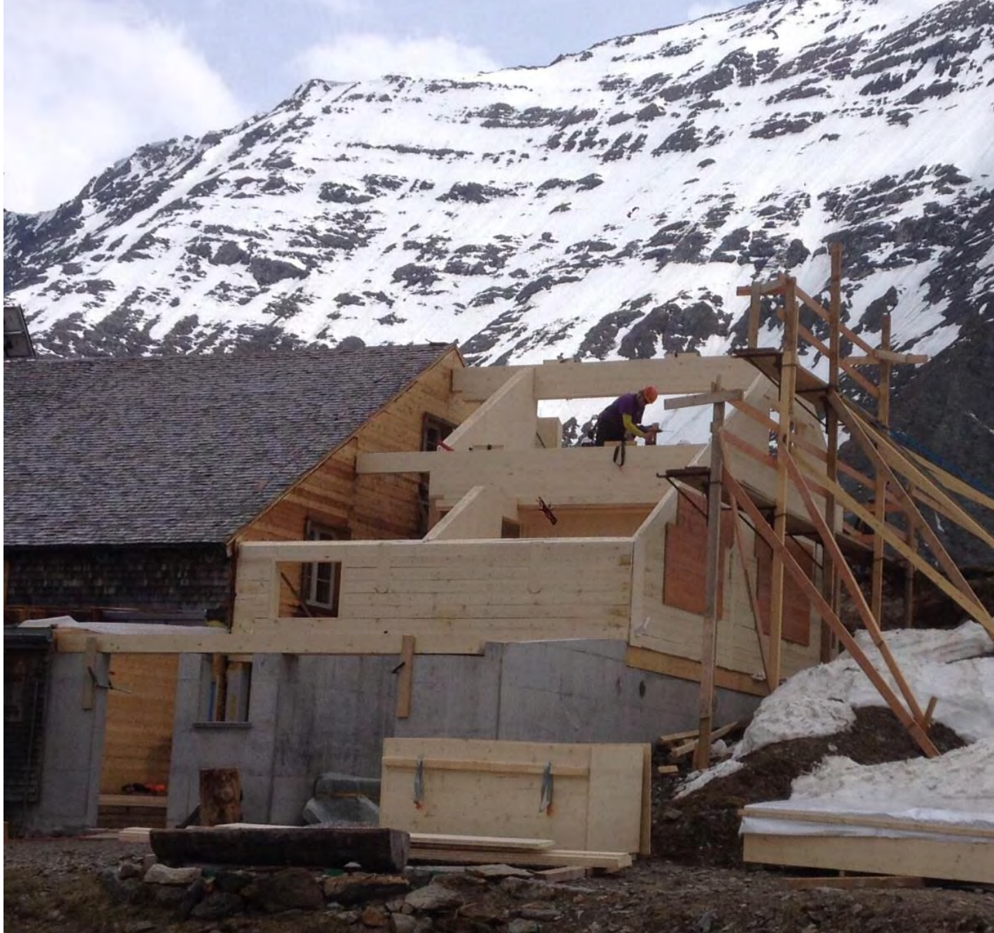
Der Hütteanbau schreitet voran
