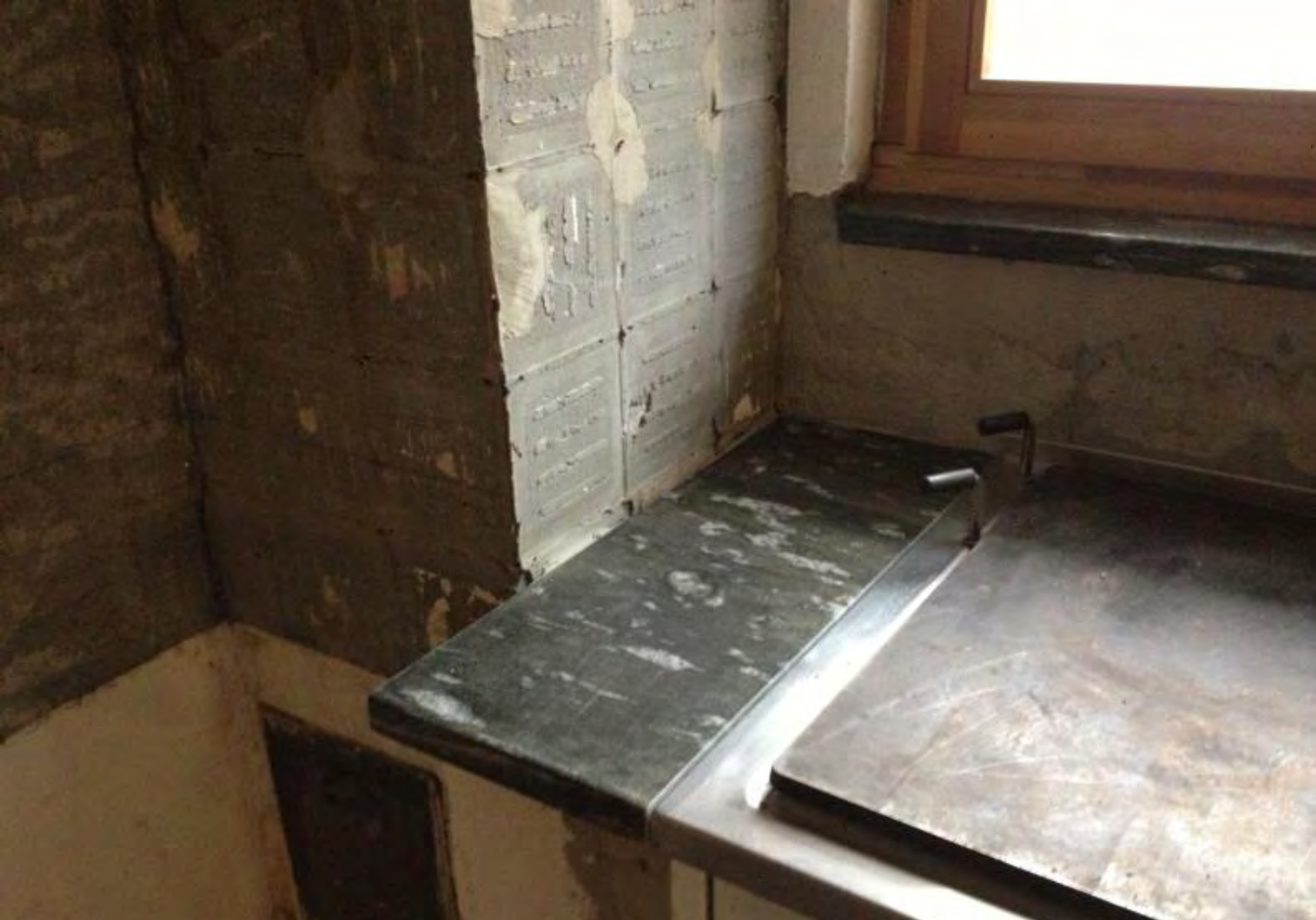
Tiba-Herd versetzt und neuen Kaminanschluss erstellt
