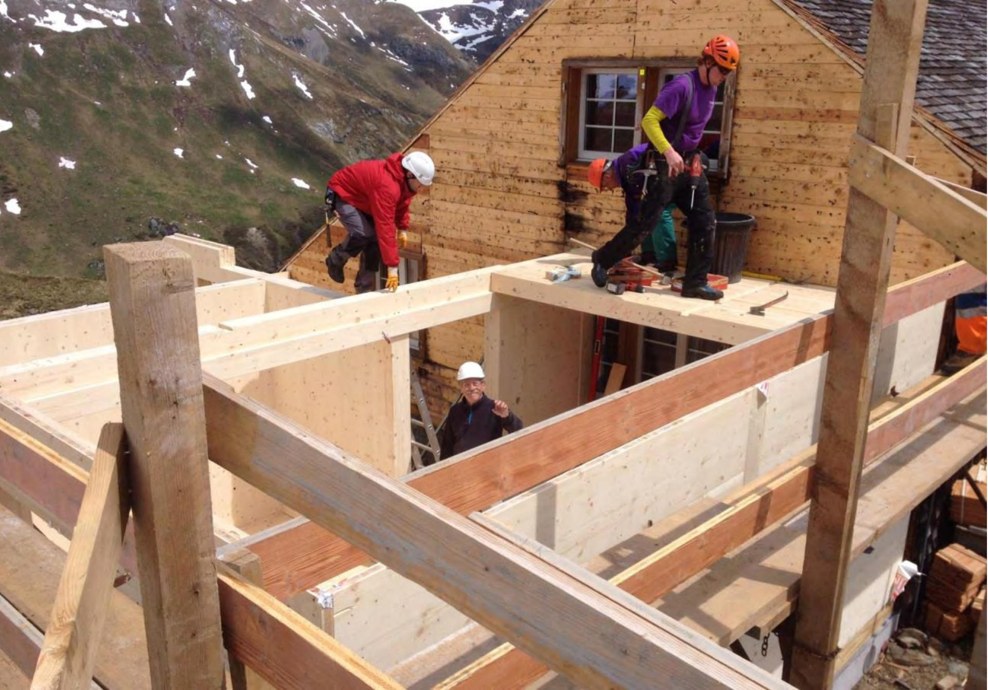
Holzbauer der Firma Nägeli, Gais beim Aufrichten
