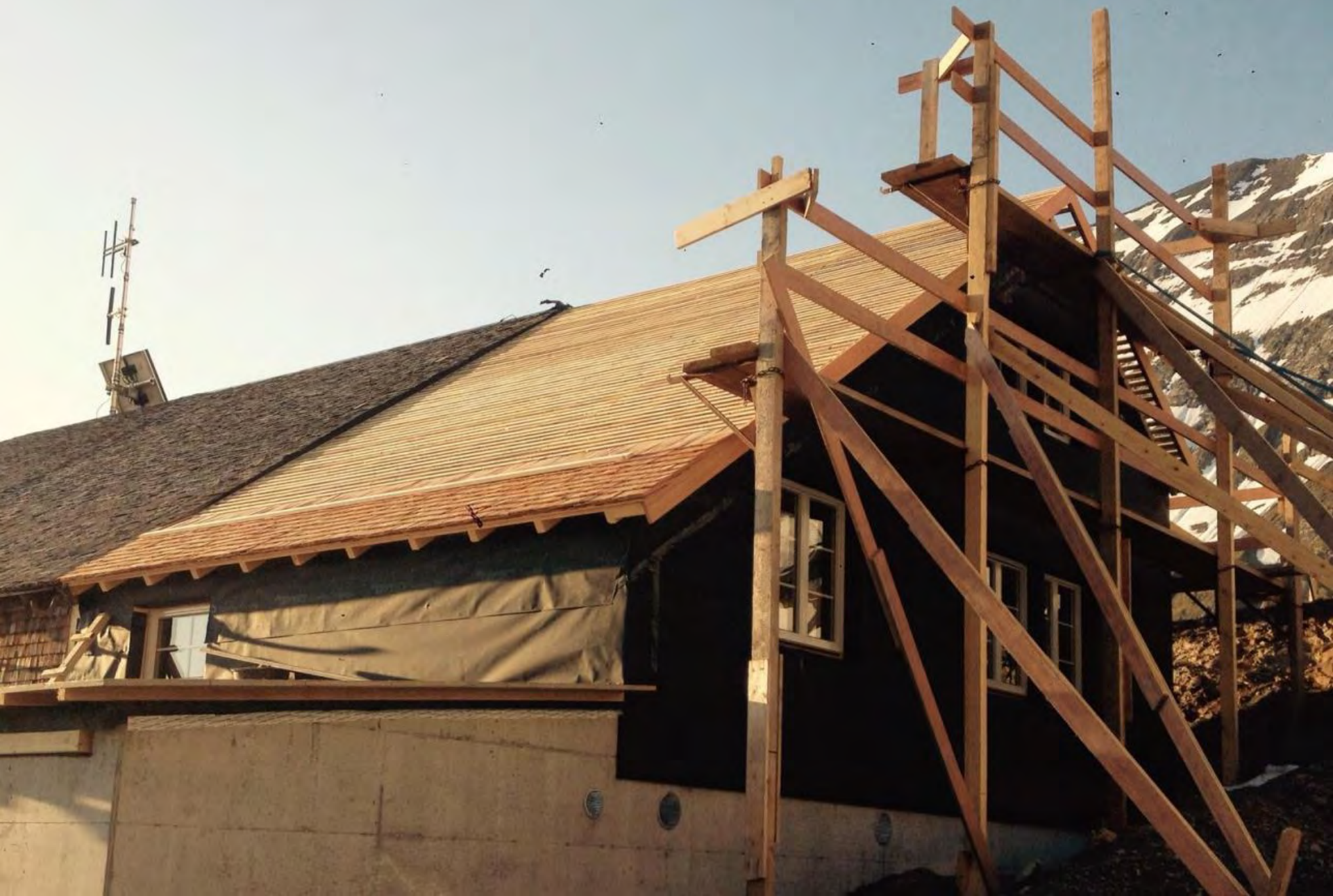
Im Rohbau fertig aufgerichtete Hütte
