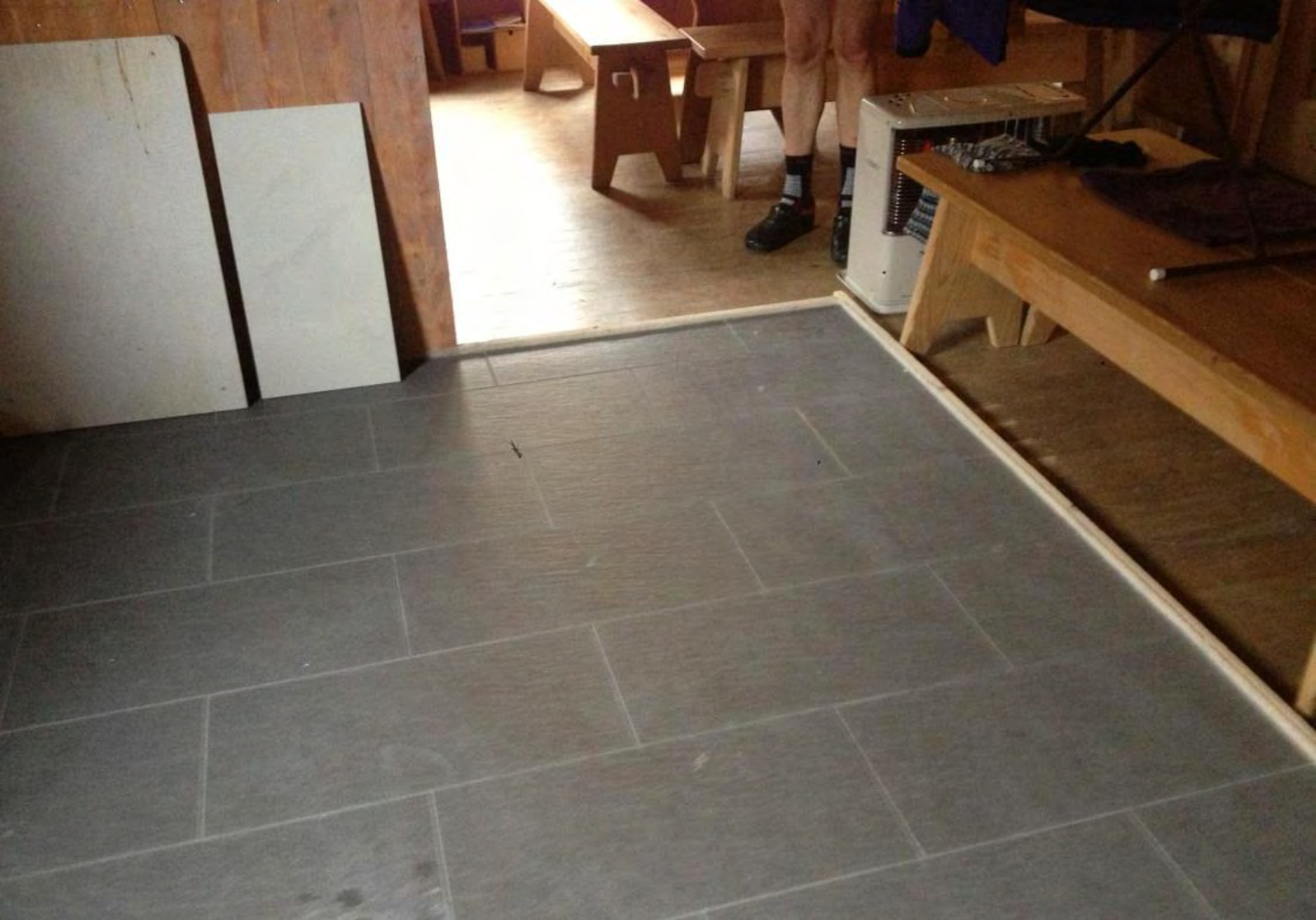
Neuer Plattenboden in Küche
