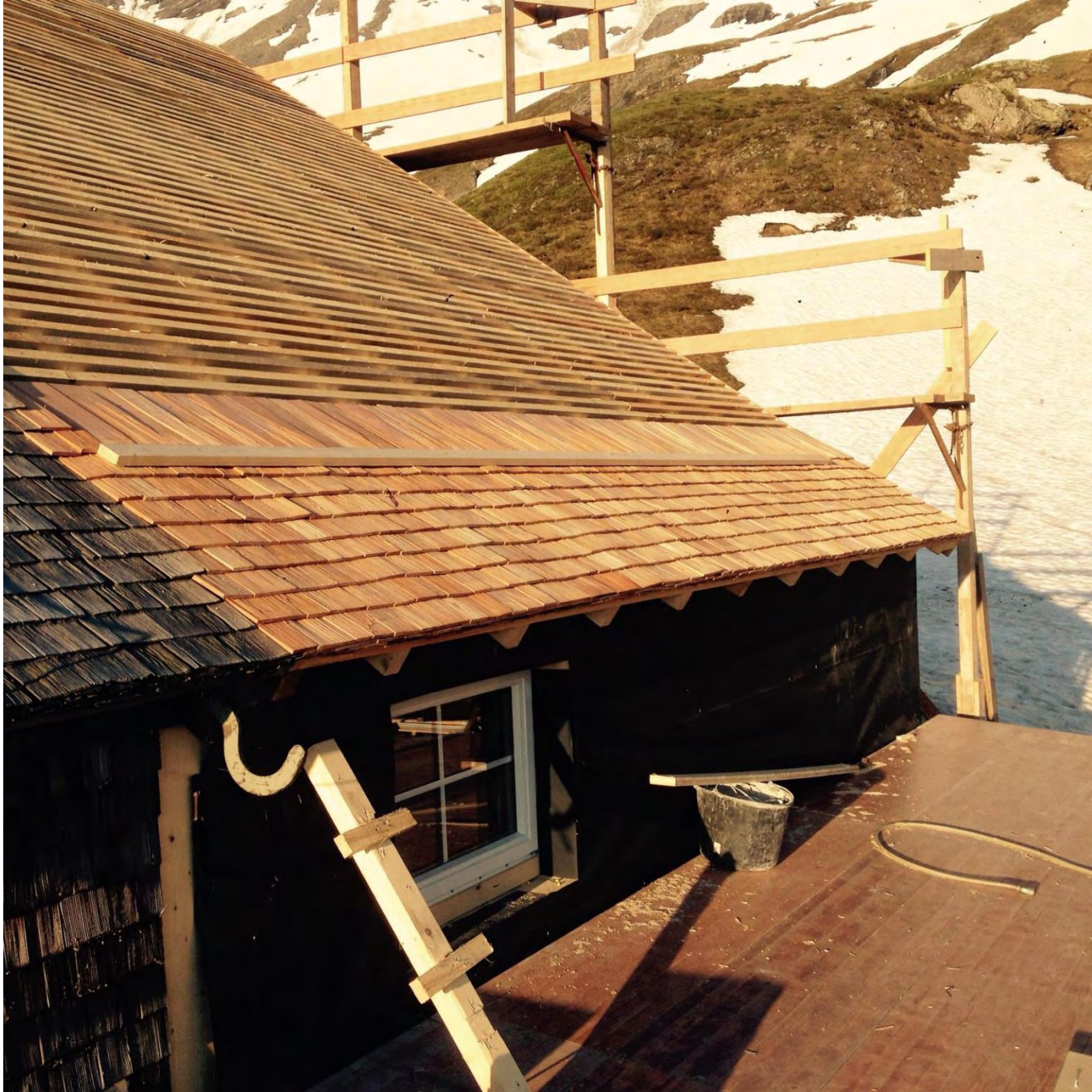
Schindelarbeiten am Dach
