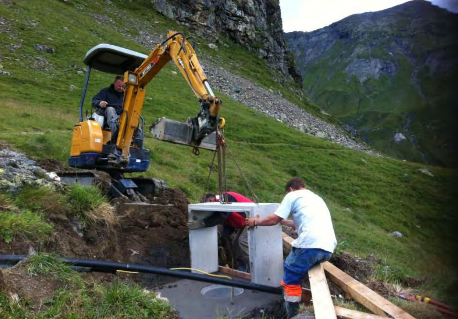
Turbinenhaus versetzen
