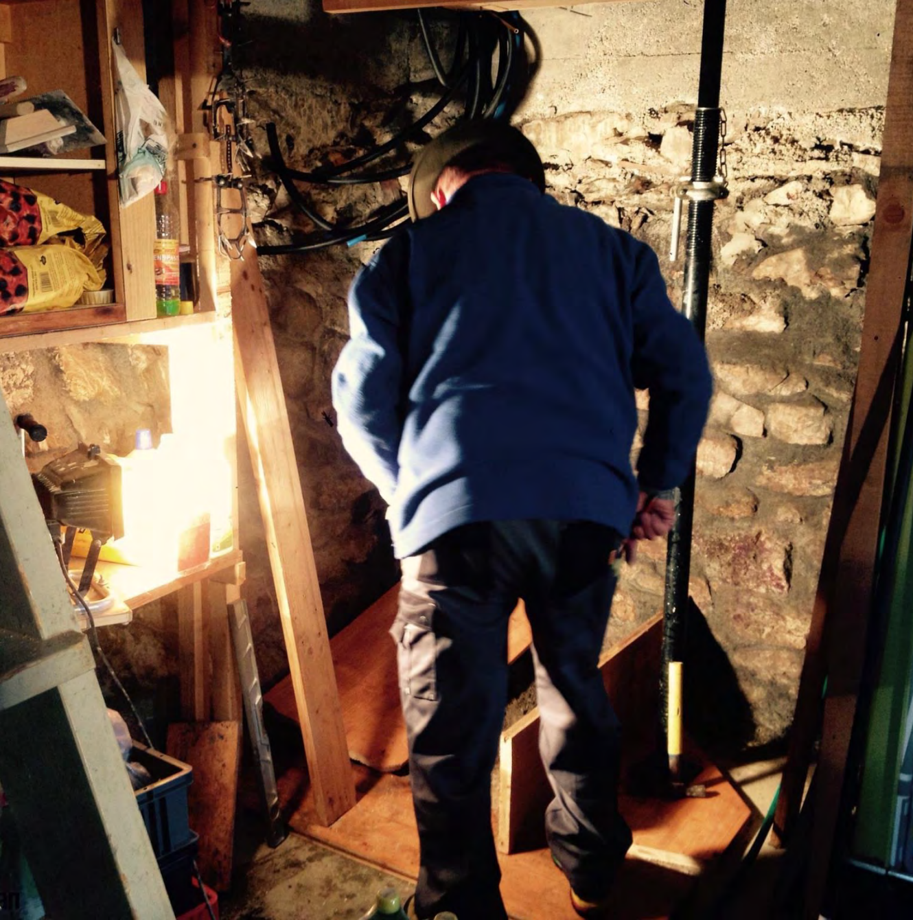
Walter Vögeli betoniert den Boilersockel
