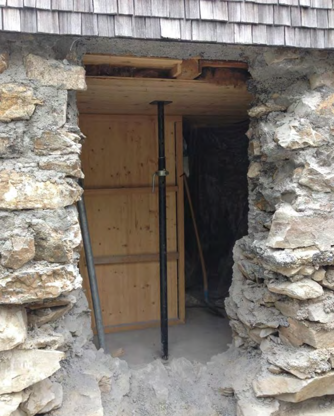
Durchbruch der bestehenden Hüttenwand
