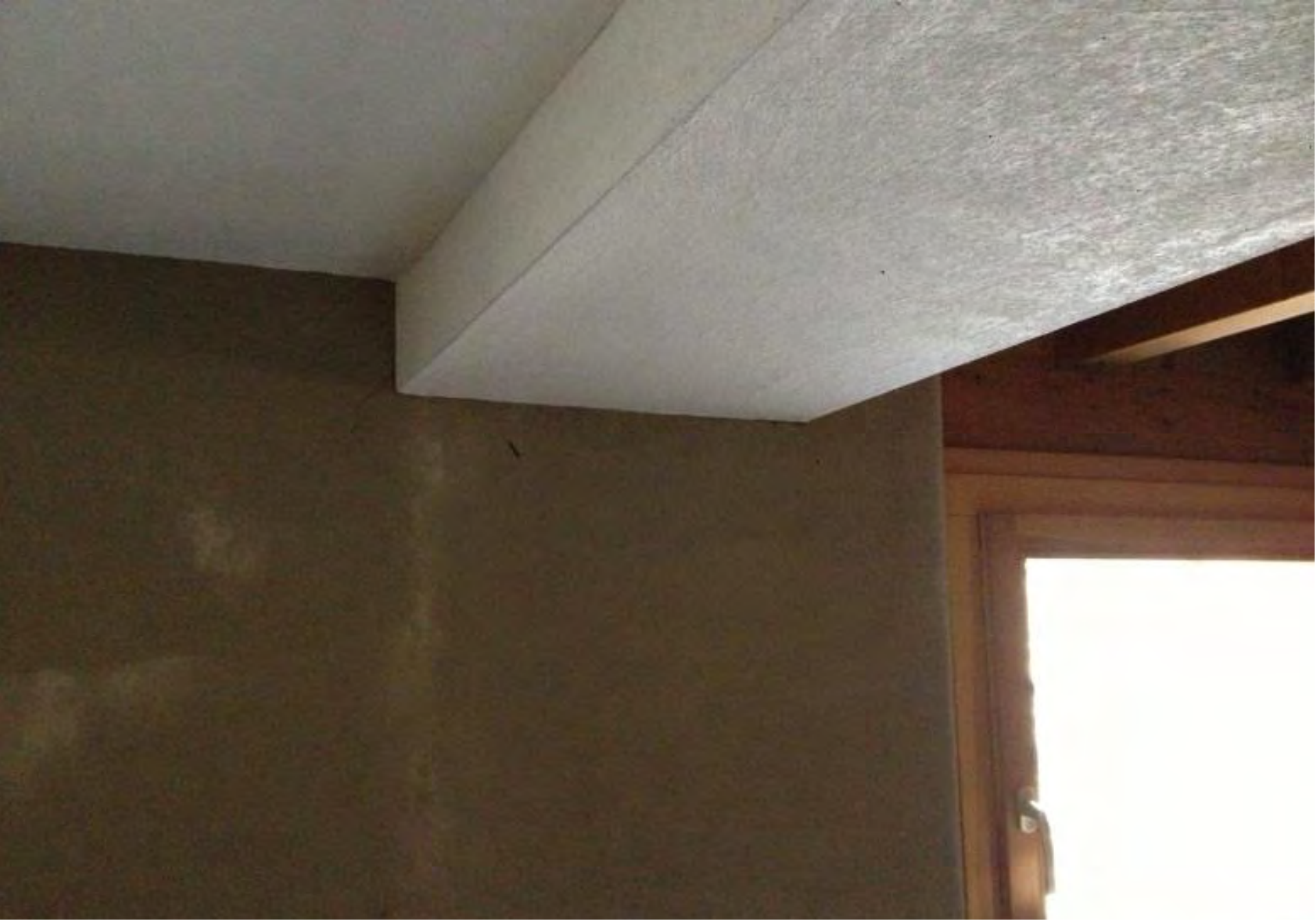
Alte Decken in erweiterter Küche neu verputzt
