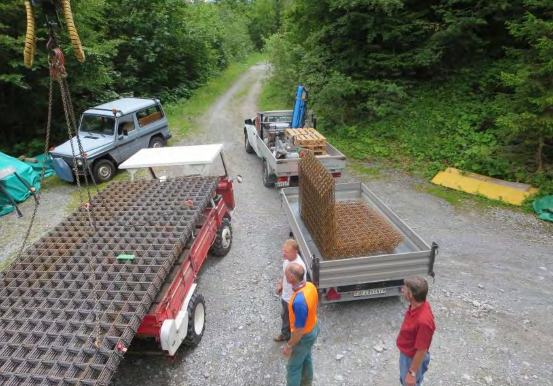
Materialumschlagplatz bei Staumauer
