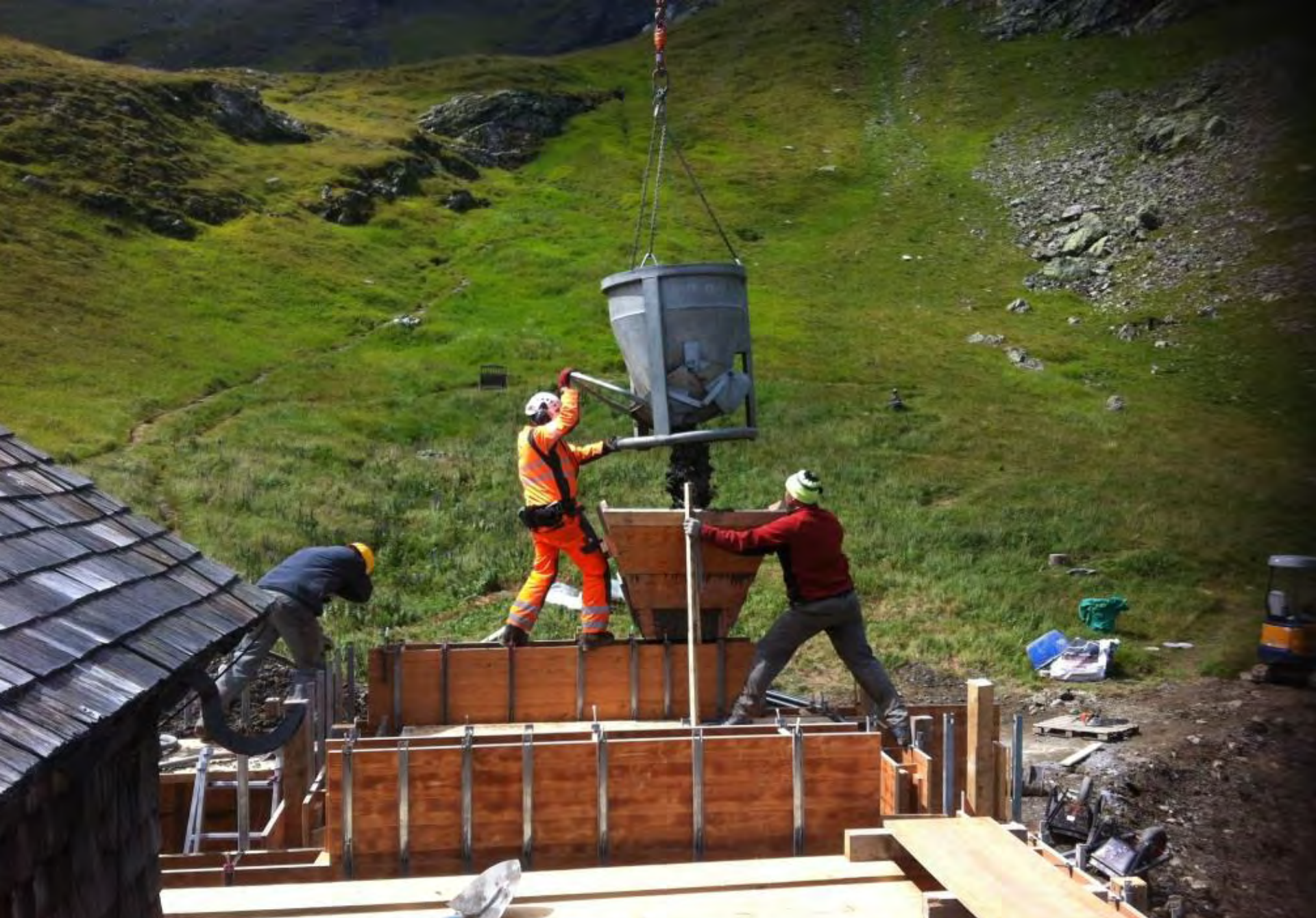
Wände mit Heli betonieren
