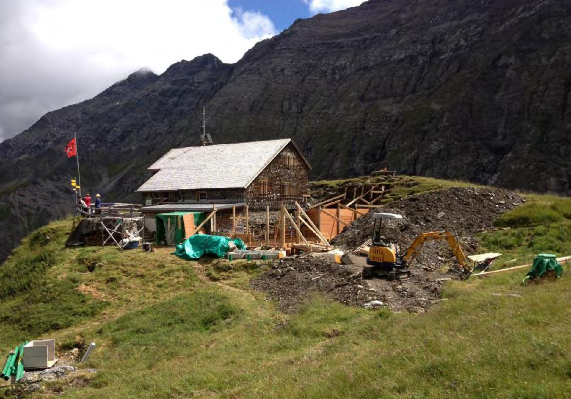
Baustellenansicht Mitte August 2014
