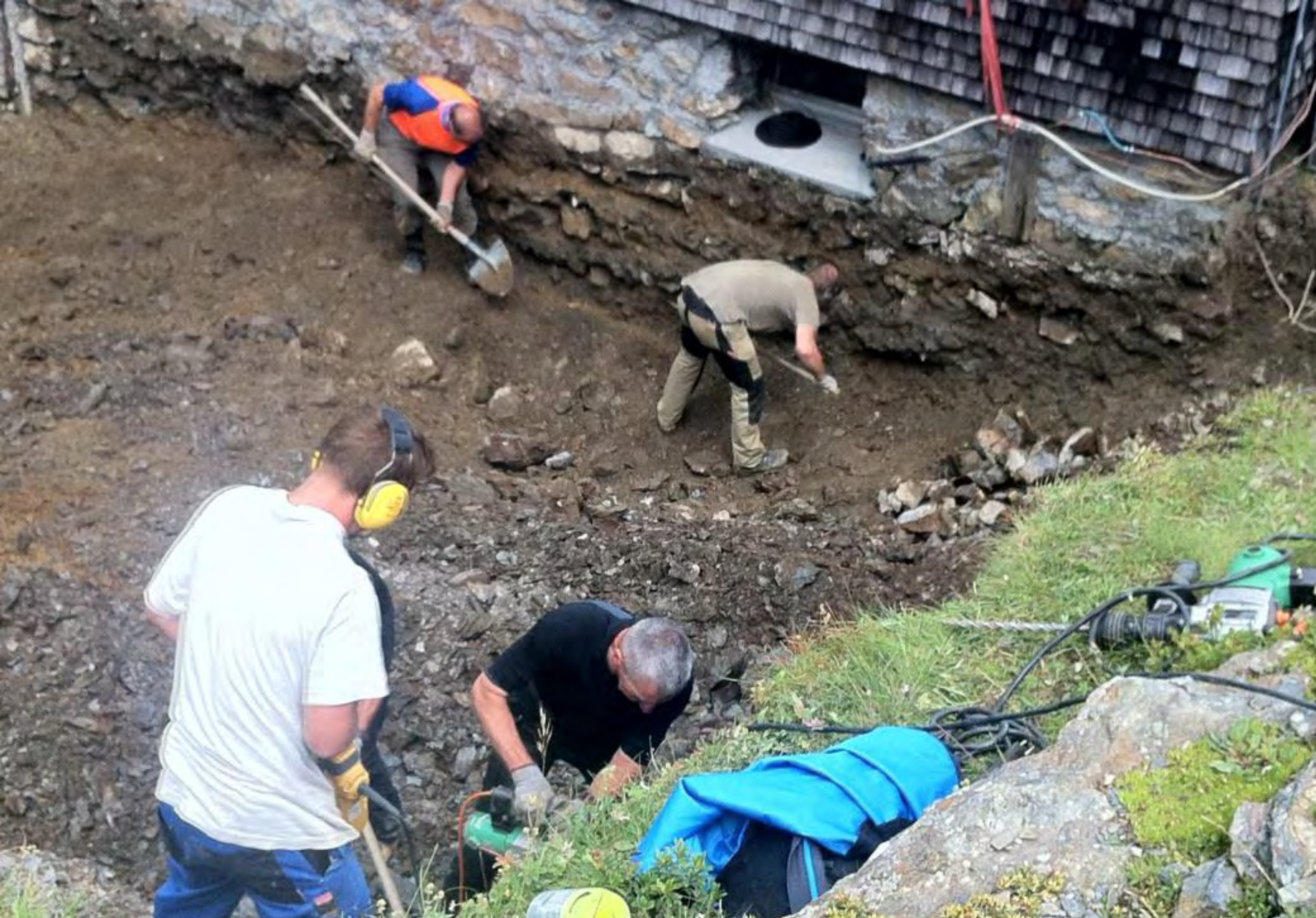
Beginn mit Aushubarbeiten am 4. August 2014
