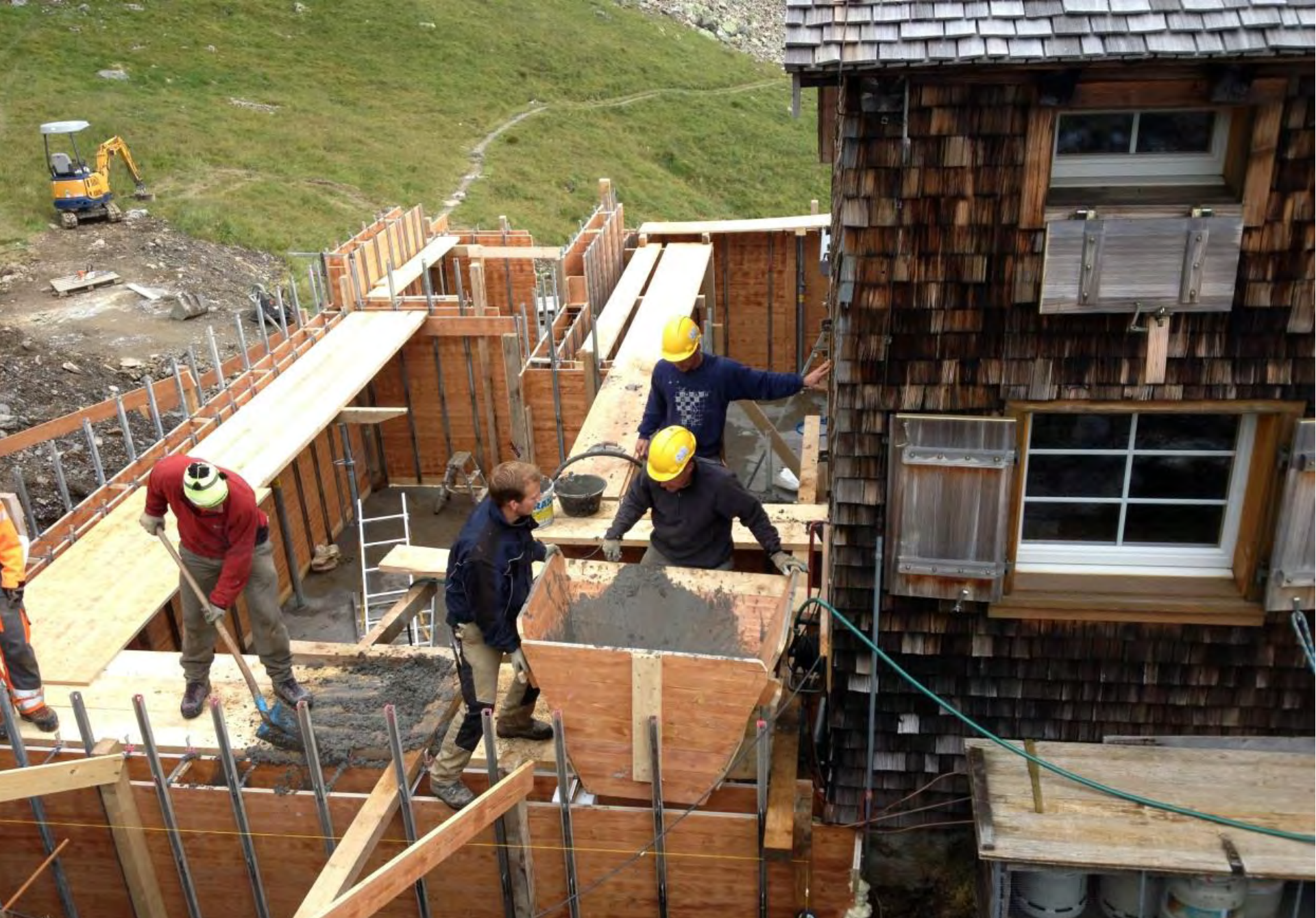
Einfülltrichter für Wände
