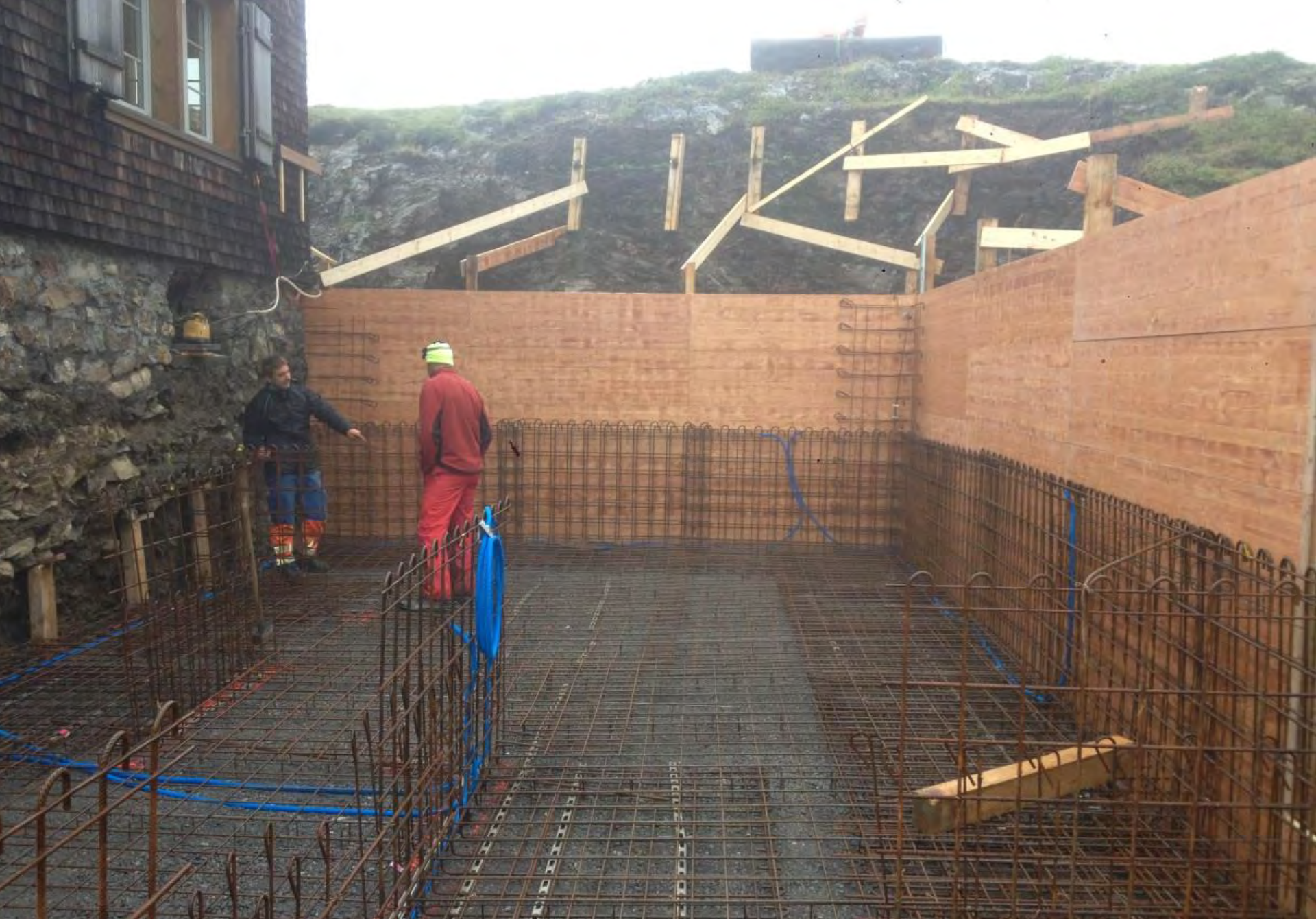
Bodenplattenarmierung verlegen
