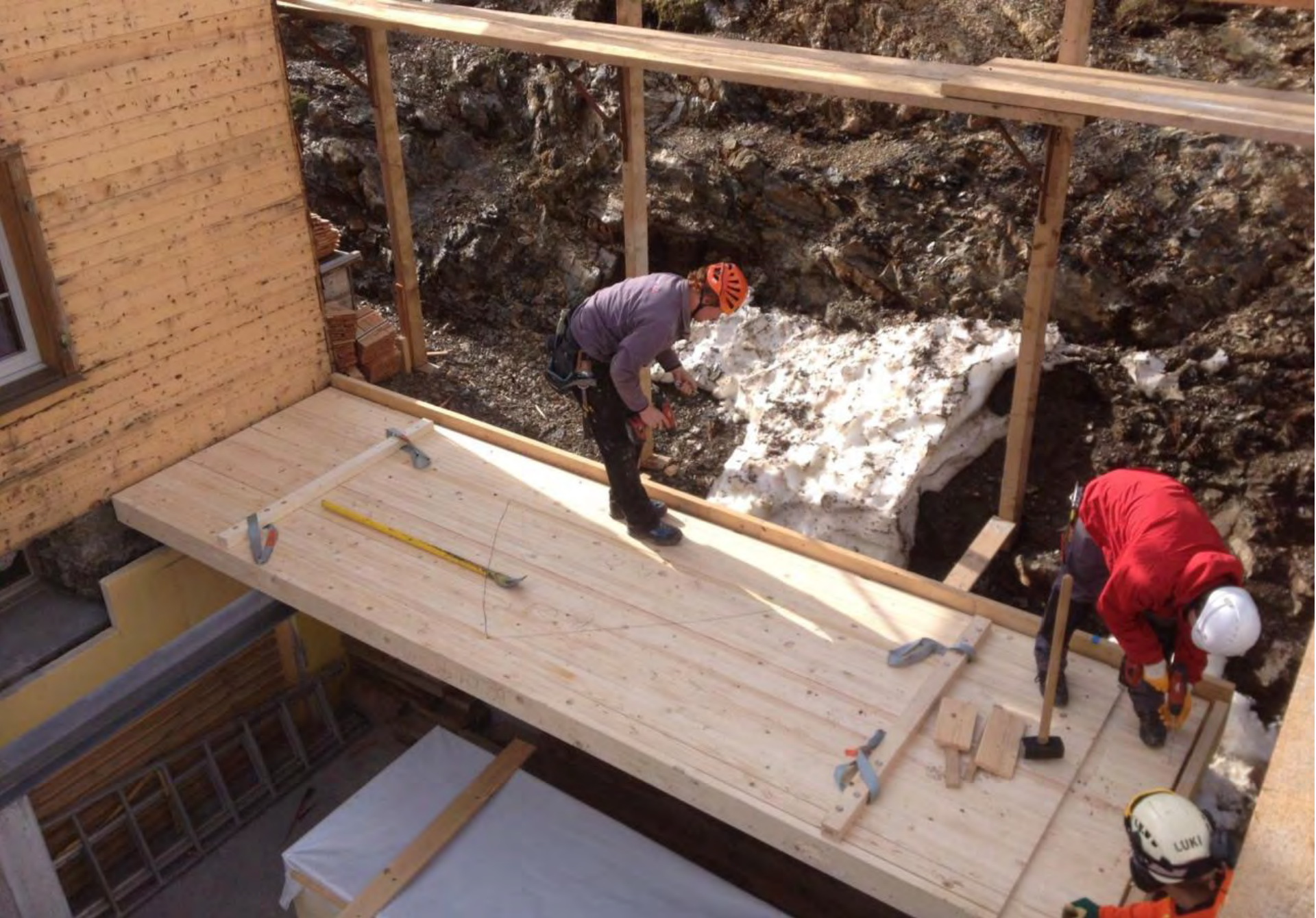
Das erste Bodenelement wird gesetzt
