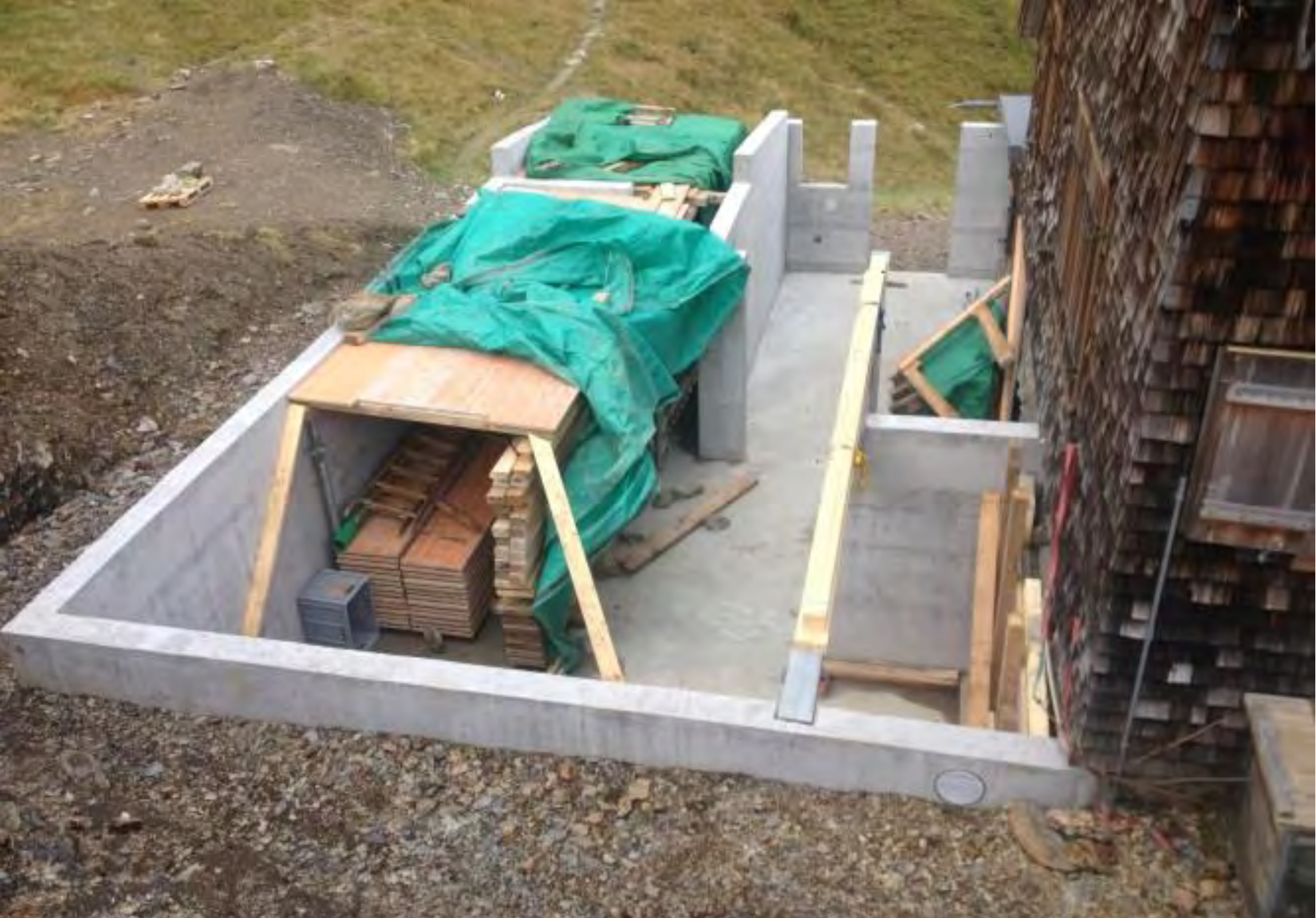
Einwinterungsarbeiten am Keller
